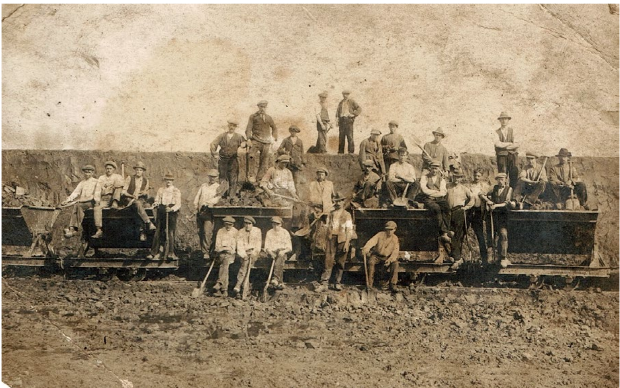
Aanleg Maas-Waalkanaal (foto HIB)
