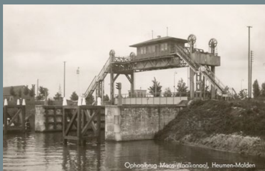
Ophaalbrug bij de sluis van Heumen (foto HIB)
