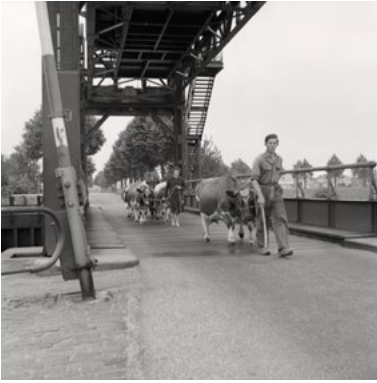
Heumen, hefbrug over de sluis (foto Beeldbank Rijkswaterstaat, inv.nr. RWS_9511)
