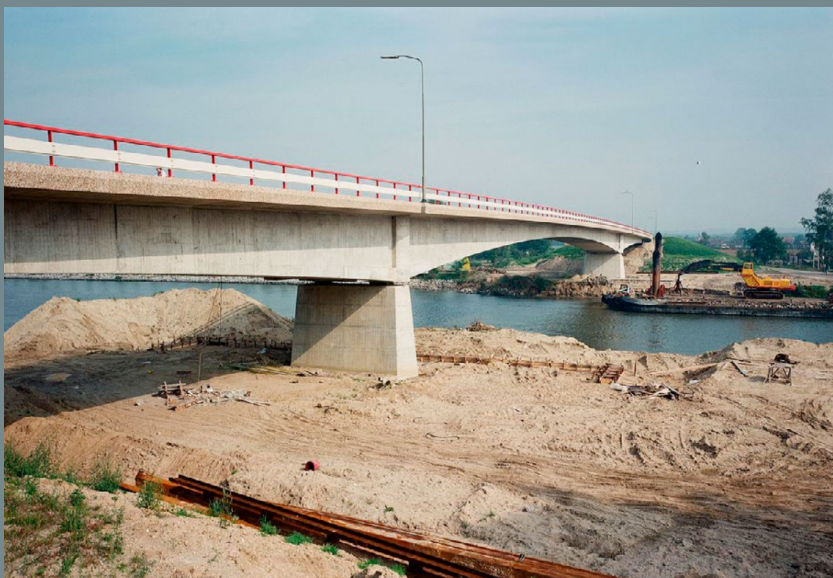
Nieuwe Maldense brug, 1988 (foto Beeldbank Rijkswaterstaat)
