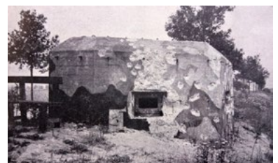
Kazemat 18, aan Maas-Waalkanaal, tussen Malden en Heumen (foto HIB)
